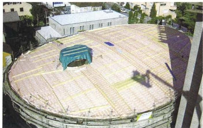
860 m<sup>2</sup> de surface de toiture a été posée avec du Sarnafil TU 222.
